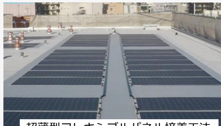
超薄型フレキシブルパネル接着工法
