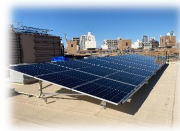
太陽光パネル設置
