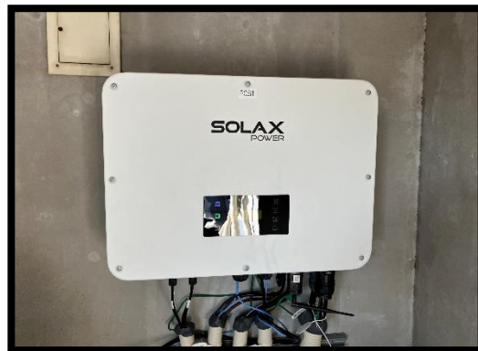
パワーコンディショナ設置
