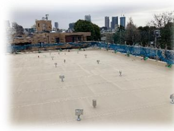
屋上 防水改修後 (架台専用基礎設置)
