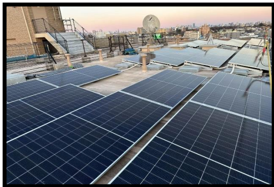
太陽光パネル設置
