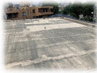
屋上 防水改修前
