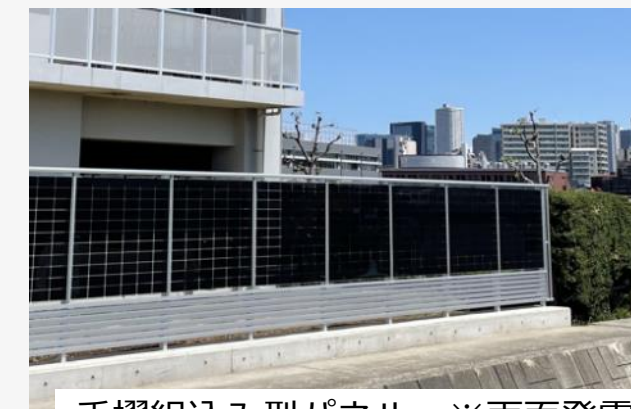
手摺組込み型パネル ※両面発電
