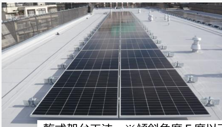
乾式架台工法 ※傾斜角度5度以下
