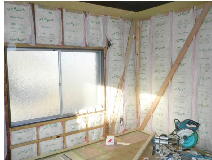
壁断熱 高性能グラスウール100mm
