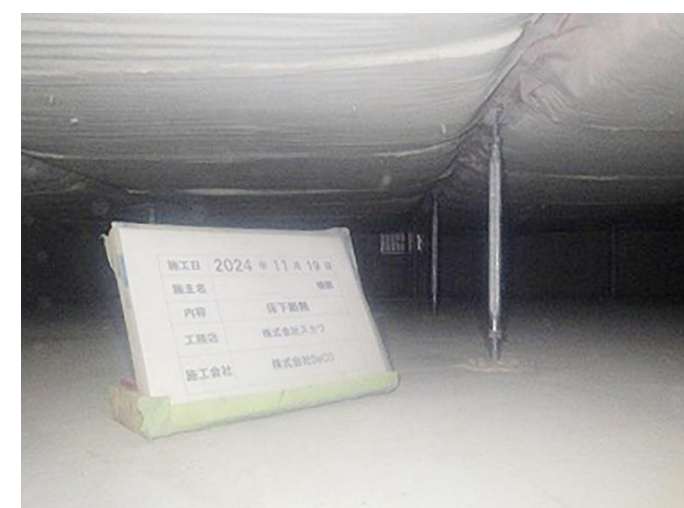
床下断熱追加 高性能グラスウール80mm
