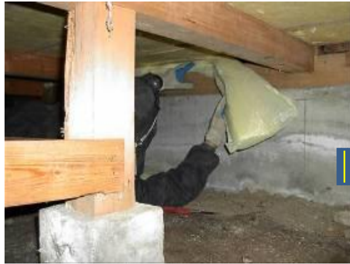
床下から気流止めを施工した例
