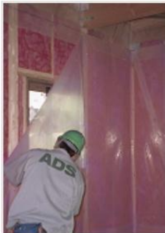
断熱材及び防湿気密シートの施工
