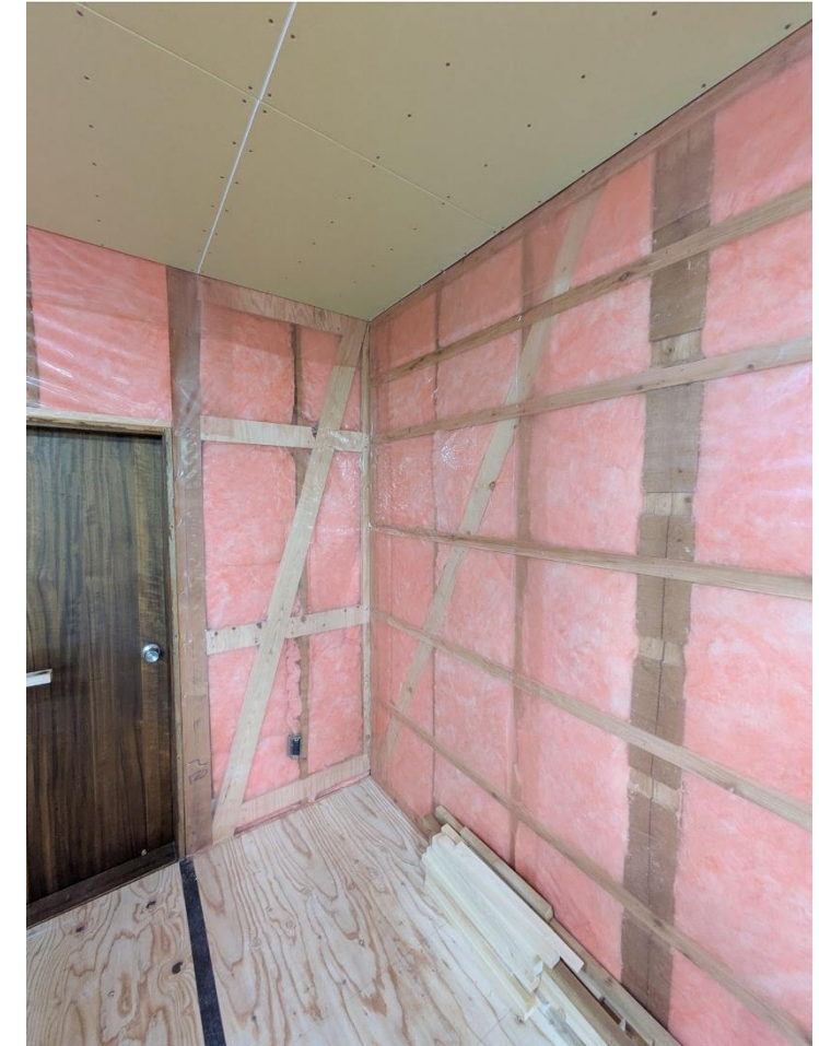
壁断熱 高性能グラスウール105mm
