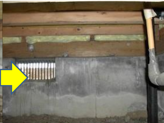
床下から気流止めを施工した例
