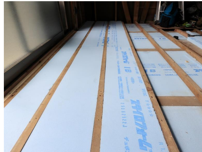
床断熱 ポリスチレンフォーム40mm+40mm
