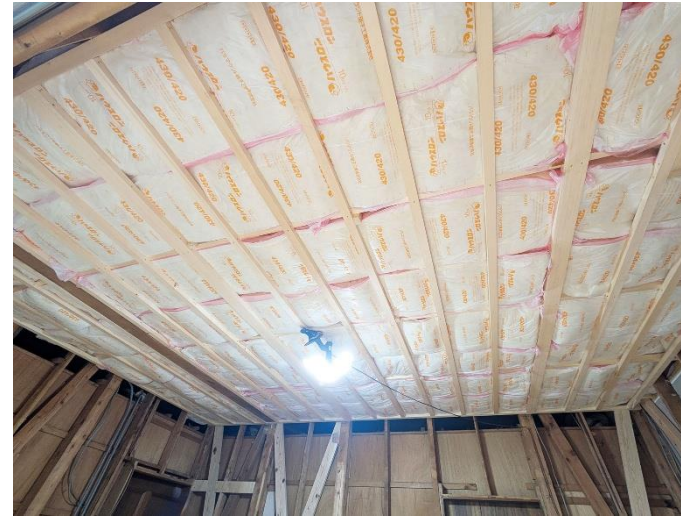
天井断熱 高性能グラスウール200mm
