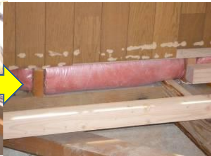
天井と間仕切壁の取り合いに 気流止めを施工した例
