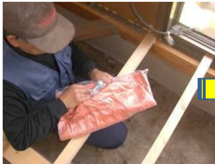
床下から気流止めを施工した例
