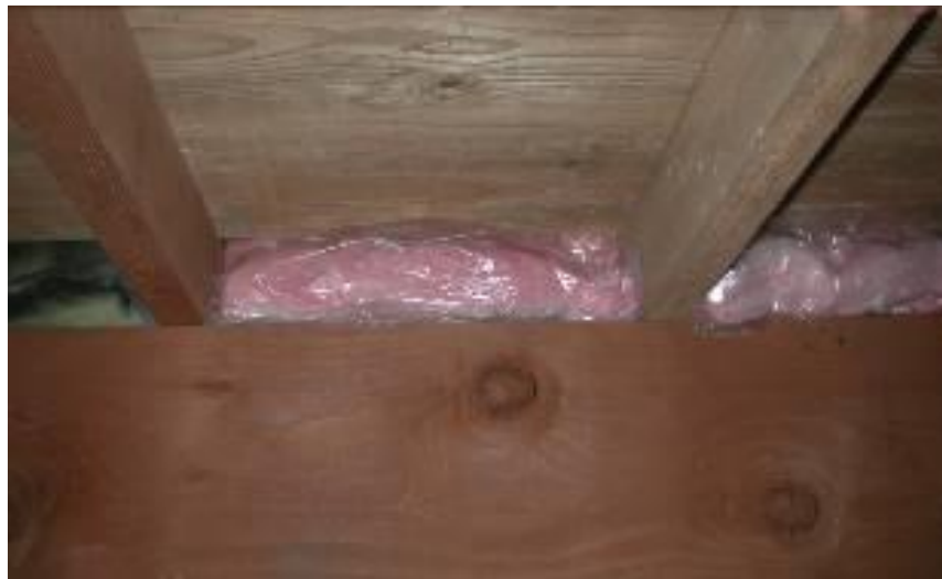
床と間仕切壁の取り合いに気流止めを施工した例
