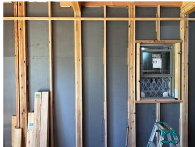
壁断熱 FX 90mm
