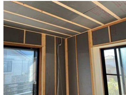
天井・壁断熱
