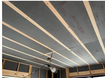
天井断熱 FX 90mm
