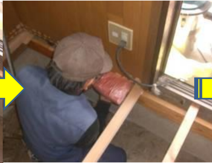
床の張り替え時に気流止めを施工した例
