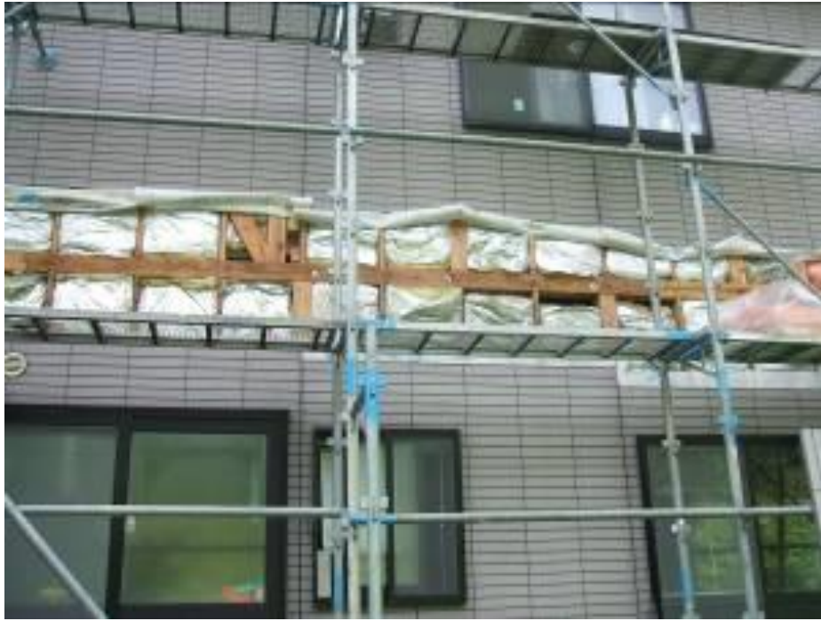
既存の外壁材を部分的に撤去して気流止めを施工した例
