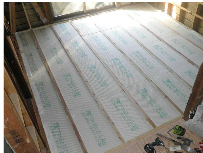
床断熱 ポリスチレンフォーム80mm
