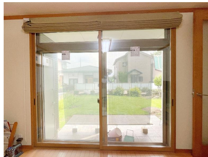
1階リビング内窓設置 樹脂サッシLow-Eペアガラス・ガス入
