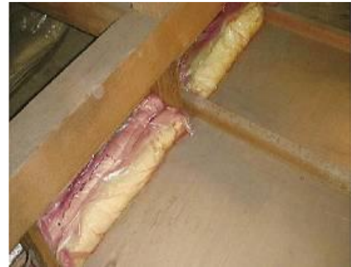
天井と間仕切壁の取り合いに 気流止めを施工した例
