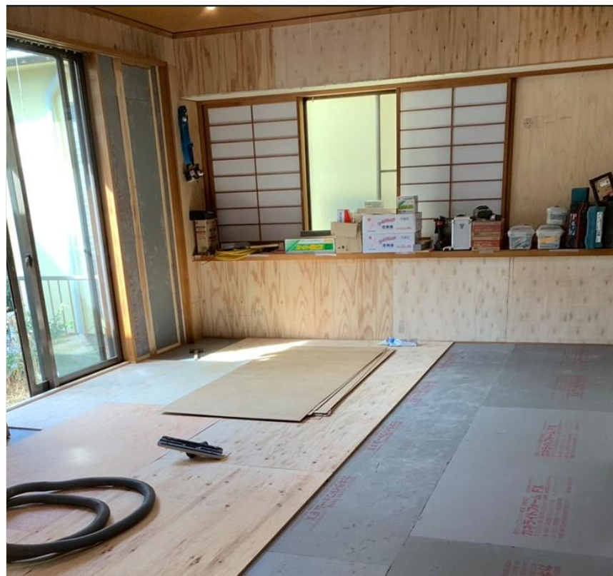
床断熱 木造建築物 床断熱施工 カネライトフォーム FX 45mm
