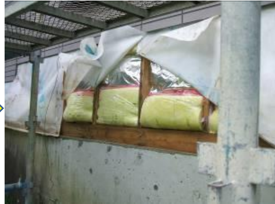
既存の外壁材を部分的に撤去して気流止めを施工した例
