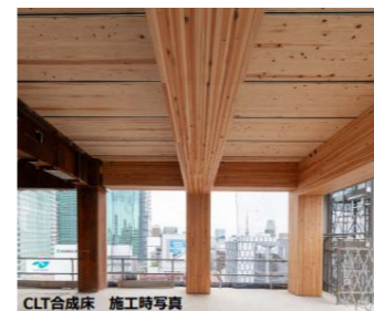
CLT合成床 施工時写真
