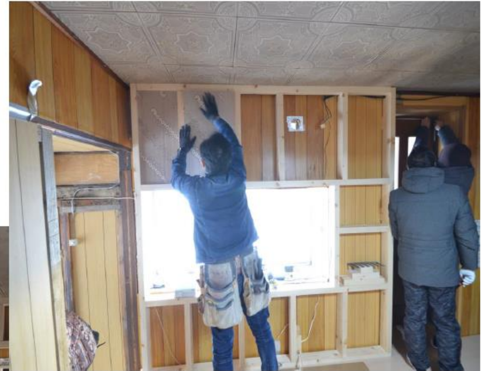
壁の断熱材を施工中
